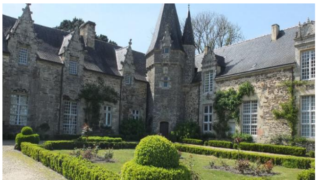
Le château de Rochefort en Terre
