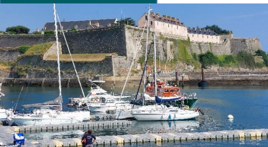
La citadelle à l'entrée du Port de Palais
